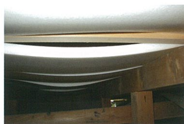
変形したボード系断熱材
