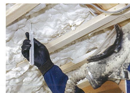
4 施工後チェック
