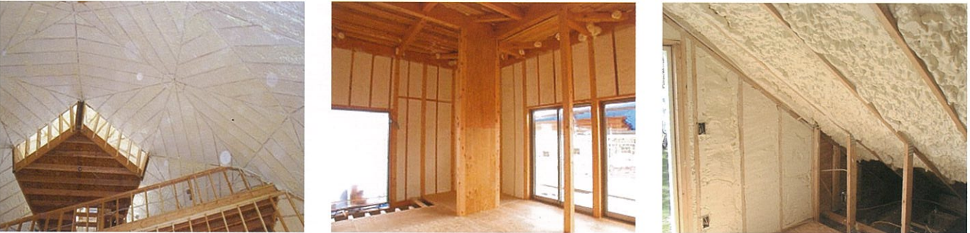
ドームハウス(屋根)
